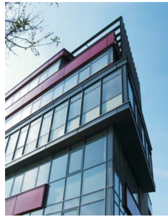
aquincum logisztikai központ, budapest bánáfi-hartvig építész iroda kft., hartvig lajos, kátai éva artifexing mérnök kft., thék eörs henrik, méry zolt
